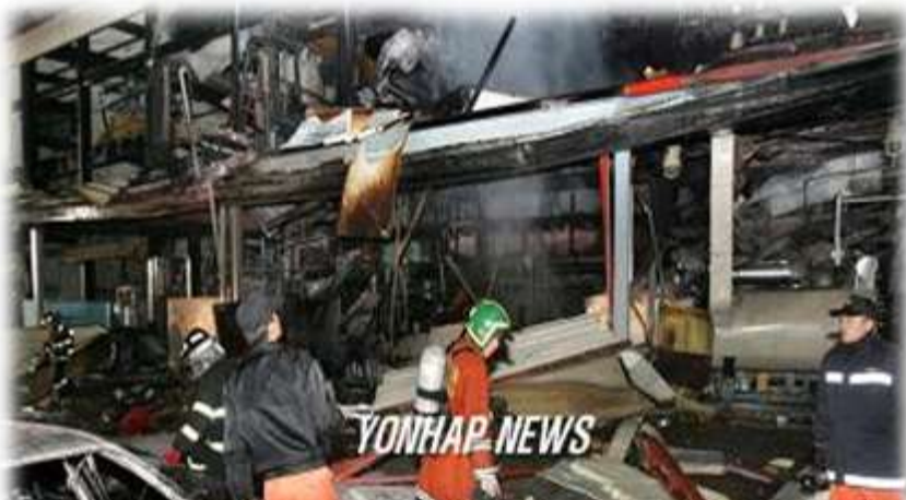
SK 대덕기술연구원 수소가스 폭발7명 부상
