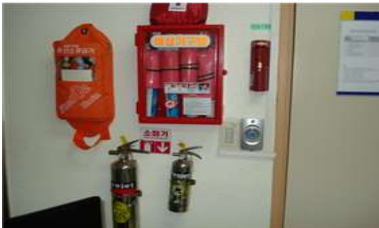
출입구에 소화기 및 비상조명 등 설치(자연대)
