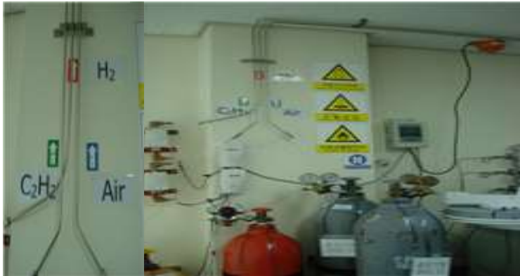
가스의 종류 및 흐름방향 표시 적정
